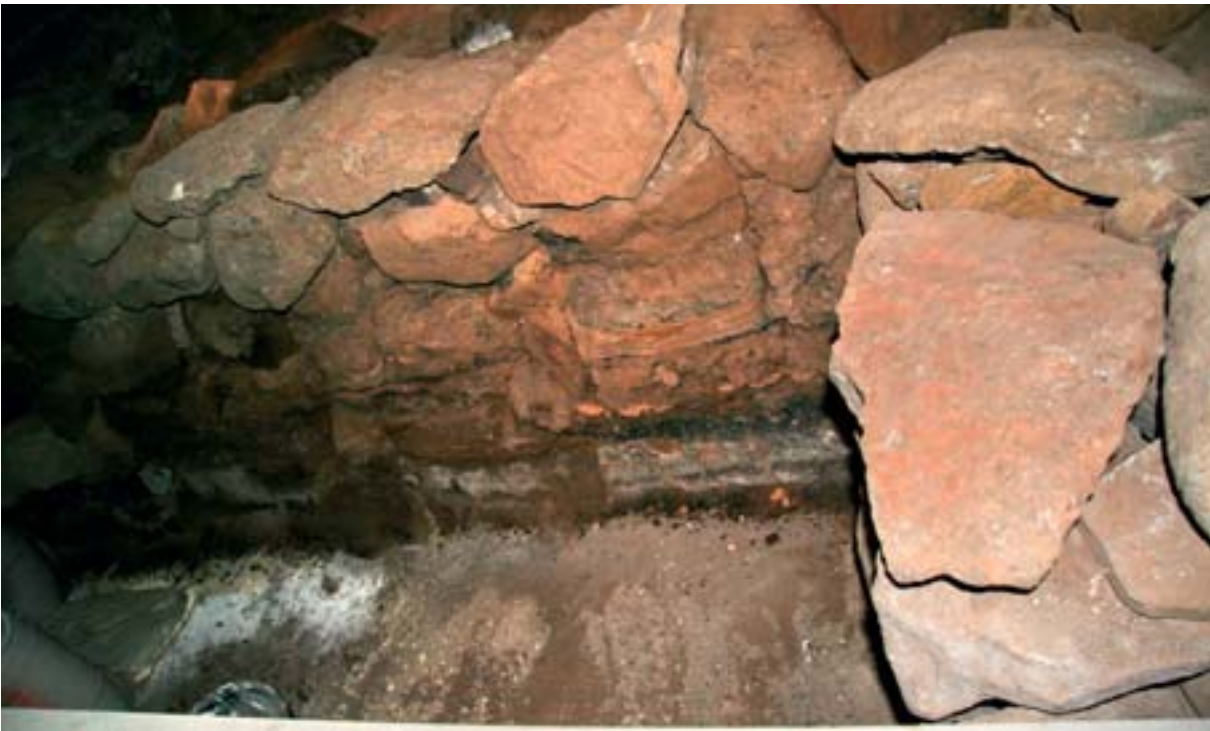
Mynd 140. Hluti af grjóthleðslu undir norðausturhorni Bessastaðastofu, líklega frá 14.eða 15. öld. Undir veggjahleðslunni sést í eldri mannvistarlög, m.a. viðarkolalög og nokkrar gólfskánir (GÓL-2007-16-26).
