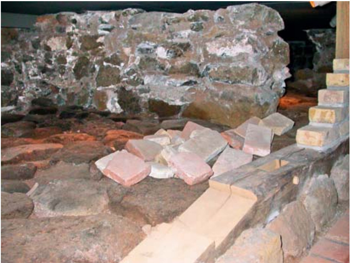
Mynd 142. Sýnir gólf og múrsteinsleifar úr veggjahleðslu frá 17. og 18. öld á svæði U 1. Í baksýn eru leifar af sökklum undir millivegg í Bessastaðastofu. Endurgerður bindingsveggur er til hægri. Fótstykkið liggur í upprunalegri rás útveggjar hússins (GÓL-2007-1-19).
